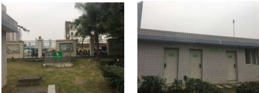
图 3.1.3-1 污水处理站现场照片
