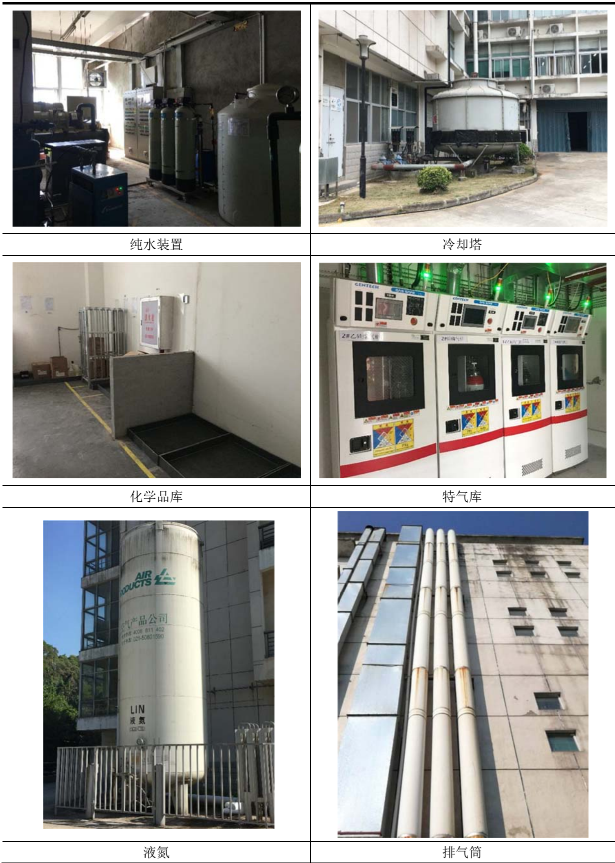
图 3.1-1 现有工程建设情况现状图
