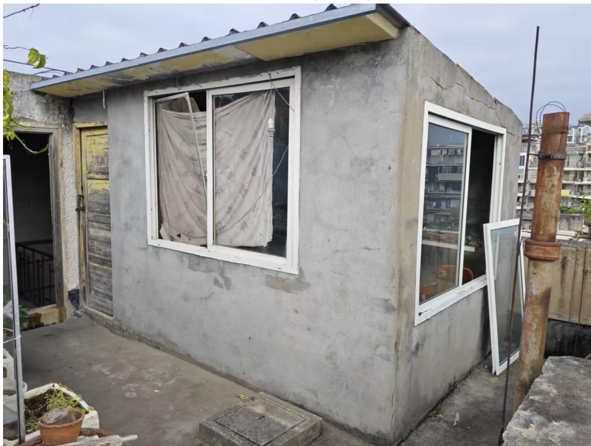
光荣小区 1 座 803 单元楼顶建筑物现场照片
