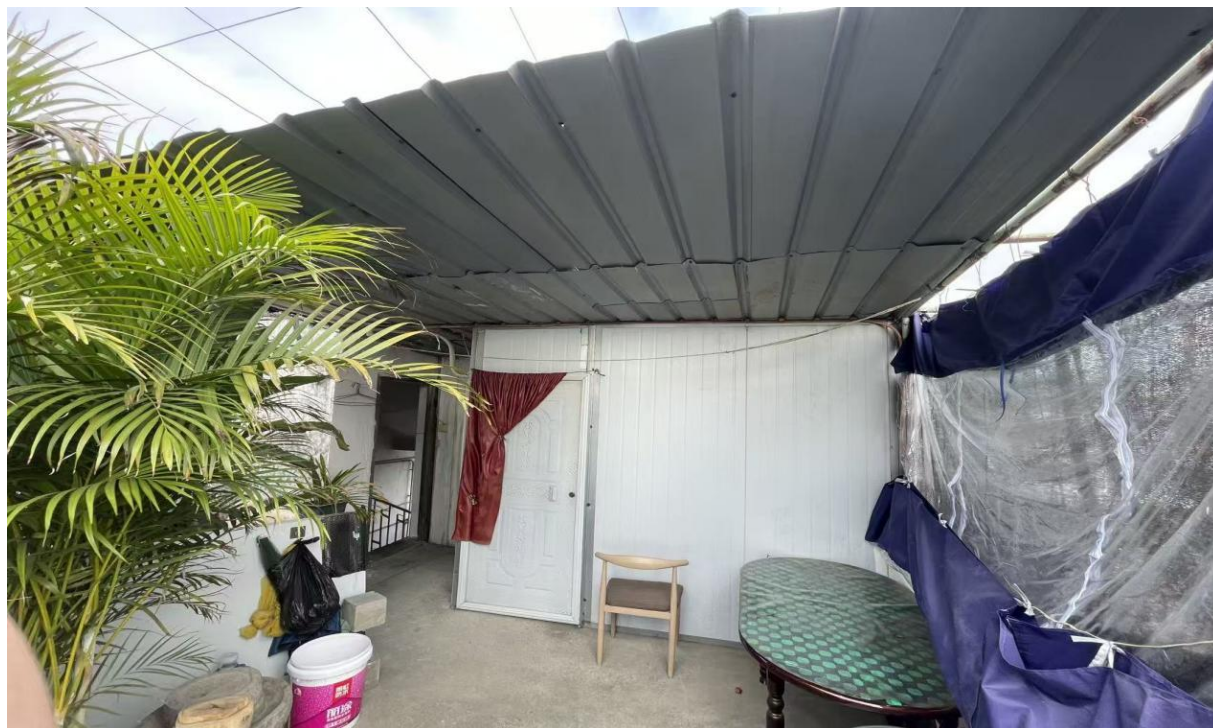
光荣小区 1 座 801 单元楼顶建筑物现场照片
