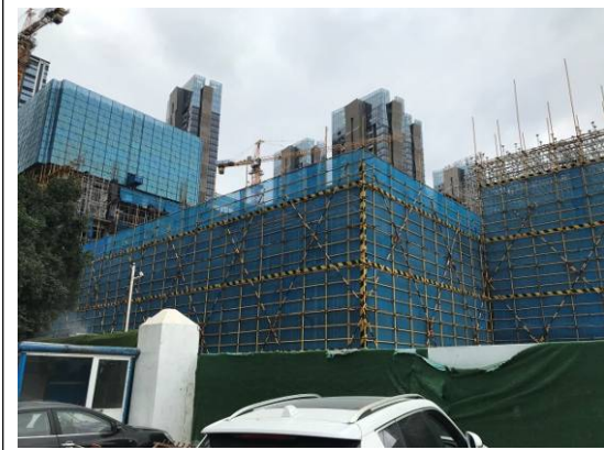
照片5 华润万象城建筑工地
