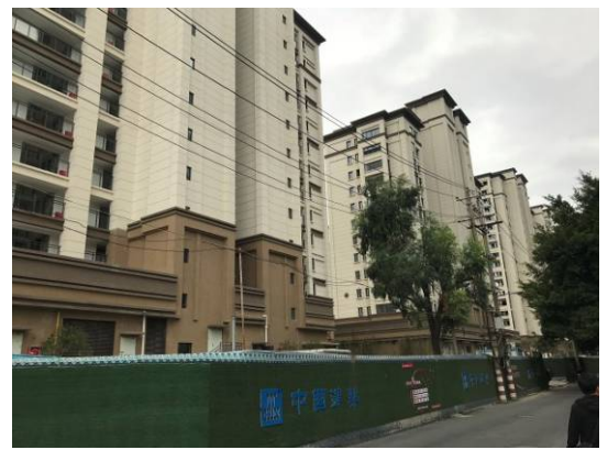
照片6 榕发乌山郡建筑工地
